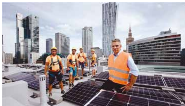
Rys. 6. Montaż instalacji fotowoltaicznej prosumenta zbiorowego na budynku w centrum Warszawy
