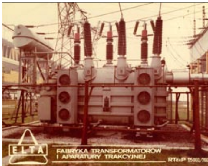
Rys. 2. Autotransformator RTdxP 125000/200 na stanowisku pracy
