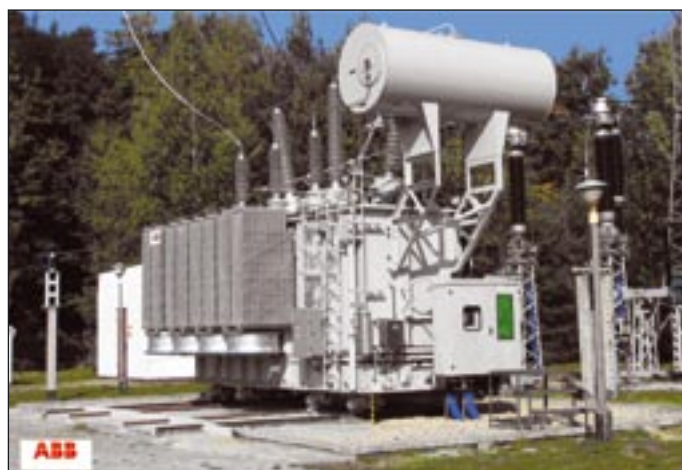
Rys. 3. Autotransformator ANAR3F 160000/220 PN na stanowisku pracy
