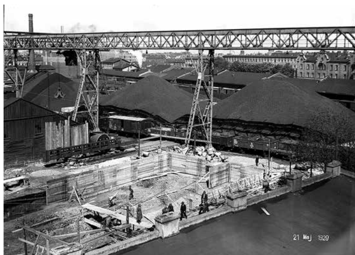
Kolejka napowietrzna do rozładunku węgla
