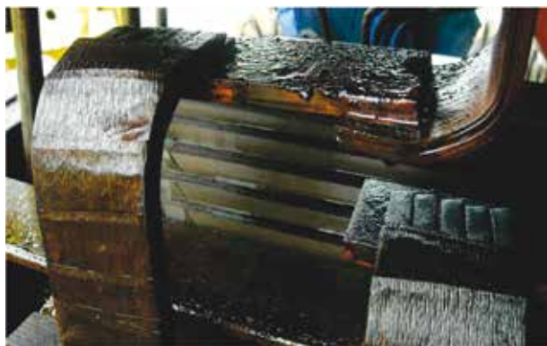
Zdjęcie 6. Ślady emulsji na części aktywnej transformatora
