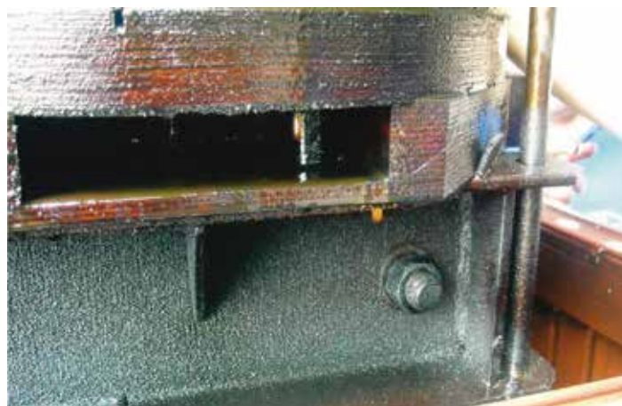
Zdjęcie 8. Ślady emulsji na części aktywnej transformatora
