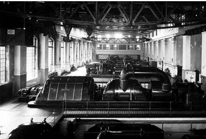
Maszynownia Centrali Wschód
