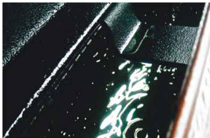
Zdjęcie 7. Ślady emulsji na części aktywnej transformatora
