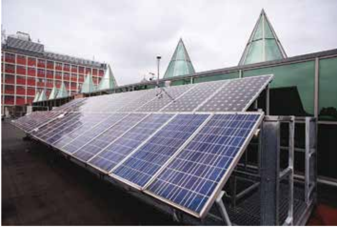
Fragment instalacji fotowoltaicznej zainstalowanej na Wydziale Elektrotechniki, Elektroniki, Informatyki i Automatyki Politechniki Łódzkiej
