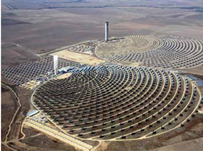
Rys. 3. Elektrownia słoneczna (PS 10 i PS 20 w Andaluzji, Hiszpania) pracująca w technologii CSP (źródło: Wikimedia Commons – repozytorium wolnych zasobów, plik PS20andPS10.jpg)
