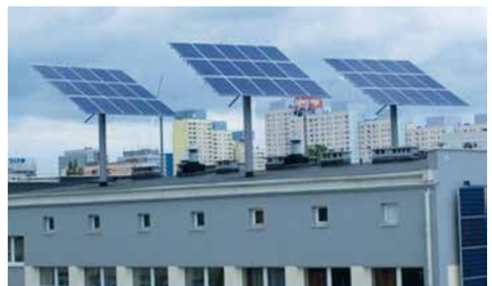
Rys. 6. Instalacji fotowoltaicznej z regulacją nadążną (moc 9,45 kW) zainstalowana w Instytucie Elektroenergetyki PŁ (źródło: www.fotowoltaika.net/fotowoltaika_galeria.html )
