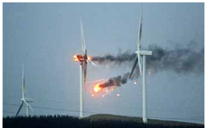
Rys. 17. Pożar turbiny wiatrowej [21]
