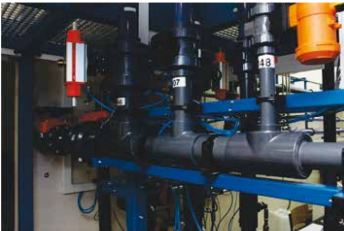
Fragment instalacji laboratorium tomografii procesowej
