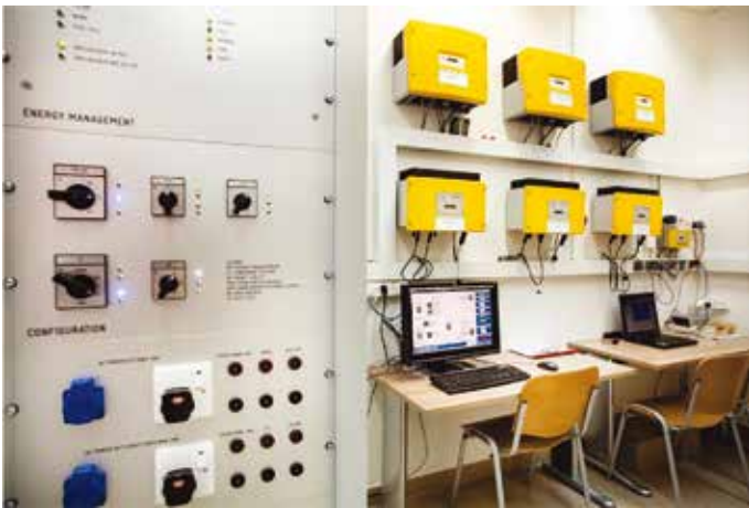
Fragment stanowiska laboratoryjnego generacji rozproszonej
