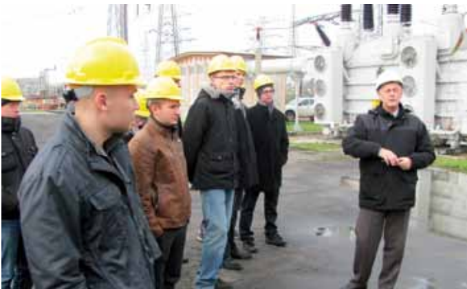
Zwiedzania rozdzielni 220 kV we Wrzosowej
