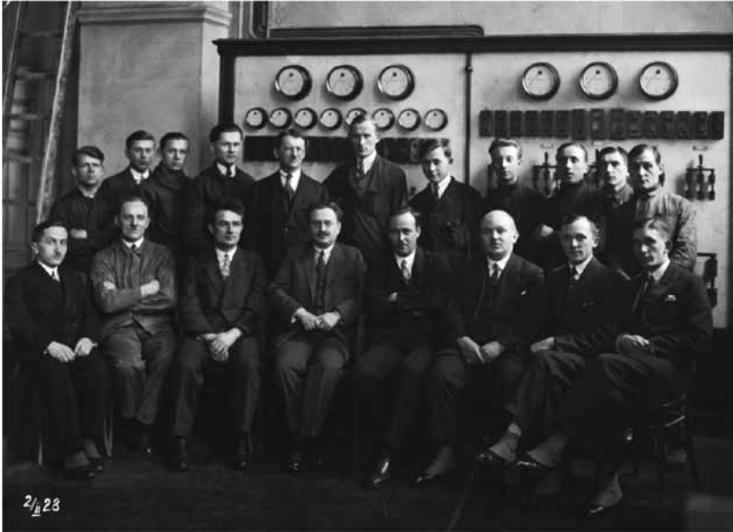
Fot. 2. W nowej rozdzielni Elektrowni Łódzkiej 2.02.1928 r. (inż. Cz. Dąbrowski siedzi trzeci od prawej)
