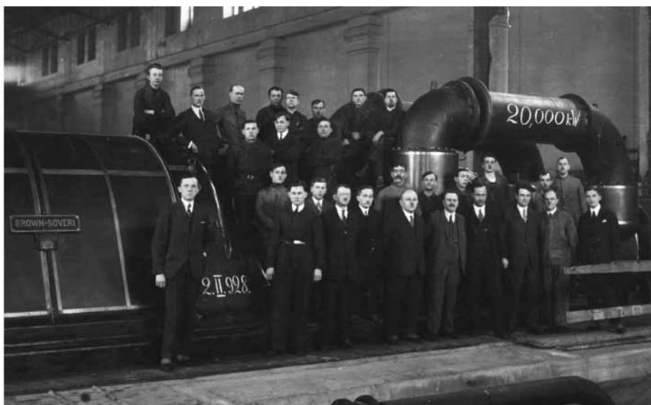
Fot. 1. Oddanie do eksploatacji w Elektrowni Łódzkiej nowego turbozespołu 20 MW – 2.02.1928 r. (inż. Cz. Dąbrowski stoi w pierwszym rzędzie piąty od prawej)
