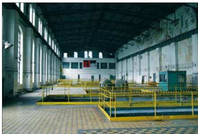
Maszynownia Centrali Wschód
