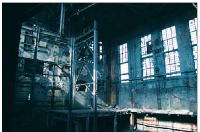
Wnętrze kotłowni Centrali Wschód sprawia przygnębiające wrażenie
