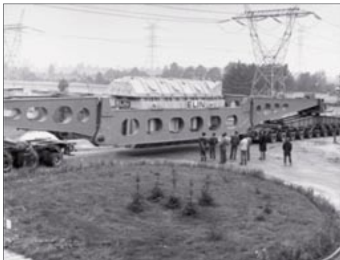
Uruchomienie stacji transformatorowo-rozdzielczej „Rogowiec” w Bełchatowie
