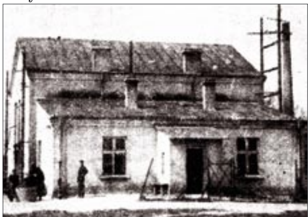
Stara, nie istniejąca już dziś elektrownia w Sieradzu
