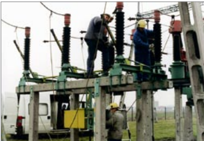
Pracownicy ZOE Sp. z o.o. dokonują przeglądu aparatury stacyjnej w stacji elektroenergetycznej Rawa Mazowiecka (1998)
