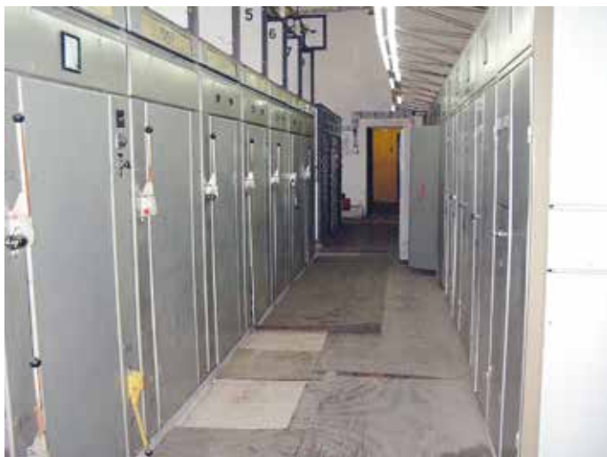
Po lewo stara rozdzielnica RSN-15 kV, po prawo stara rozdzielnica RPS
