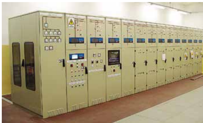
Nowa rozdzielnica RPS wraz z szafą kabli powrotnych
