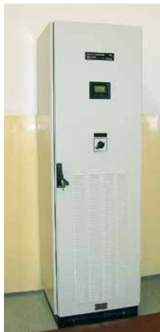
Siłownia prądu stałego
