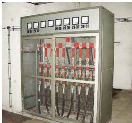
Stara szafa kabli powrotnych
