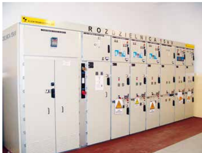
Nowa rozdzielnica RSN-15 kV
