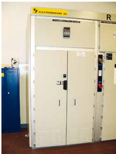
Transformator potrzeb własnych zabudowany wraz z rozdzielnicą RSN
