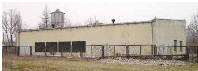
Budynek podstacji „Kopernik” przed modernizacją
