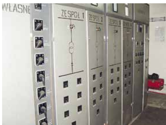
Stare pola sterujące rozdzielnicy RPS
