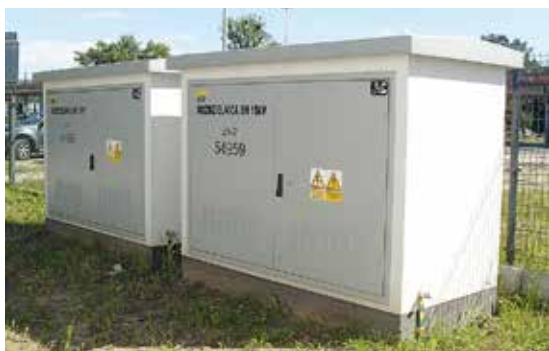
Nowe złącza kablowe 15 kV
