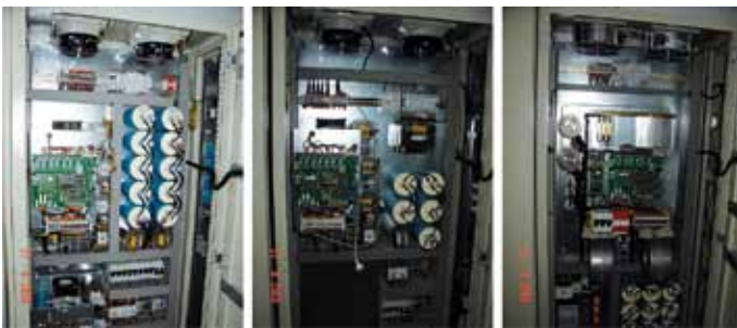
Rys. 18. Budowa wewnętrzna poszczególnych inwertorów
