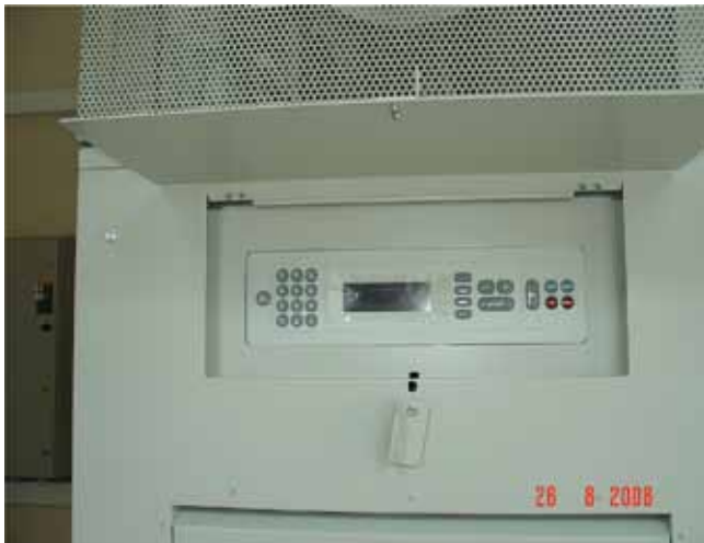
Rys. 12. Widok panelu sterującego na stronie frontowej mikroturbiny
