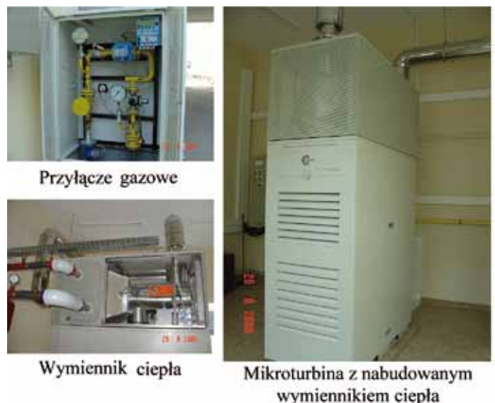
Rys. 11. Stanowisko mikroturbiny gazowej
