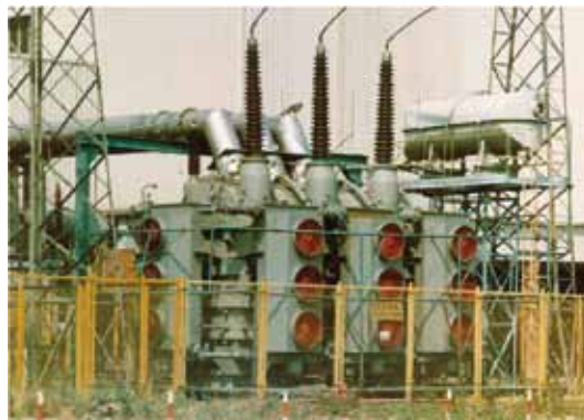
Rys. 6. Transformator blokowy 240 MV·A, 250 kV na stanowisku pracy w elektrowni
