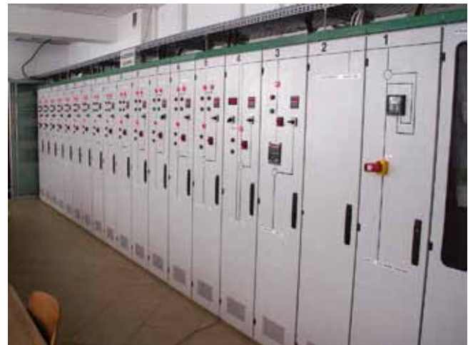
Rys. 2. Widok rozdzielni głównej laboratorium urządzeń generacji rozproszonej
