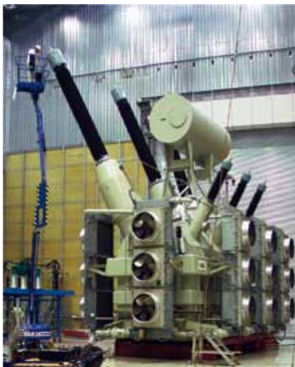
Rys. 7. Ustawiony do badań na polu probierczym stacji prób pierwszy transformator fabryki na napięcie 500 kV, o mocy 250 MV·A
