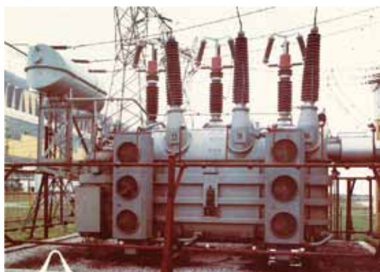
Rys. 5. Autotransformator licencyjny RTdxP 125000/200 o mocy 160 MV·A
