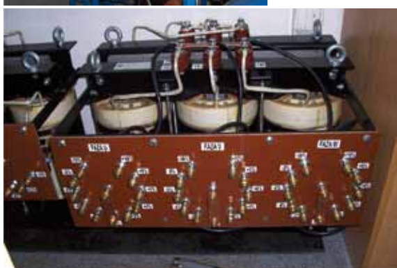
Rys. 4. Widok elementów tworzących model sieci: po lewo: dławiki i rezystory, poniżej: transformatory
