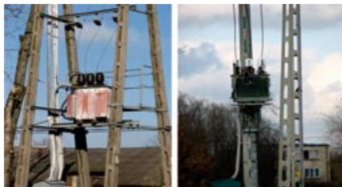
Rys. 6. Przykłady transformatorów słupowych z utrudnionym dostępem i izolacją na przepustach
