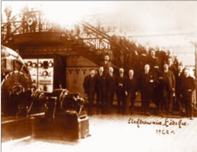
Elektrownia Łódzka. Rok 1922. Maszynownia Centrali Wschód
