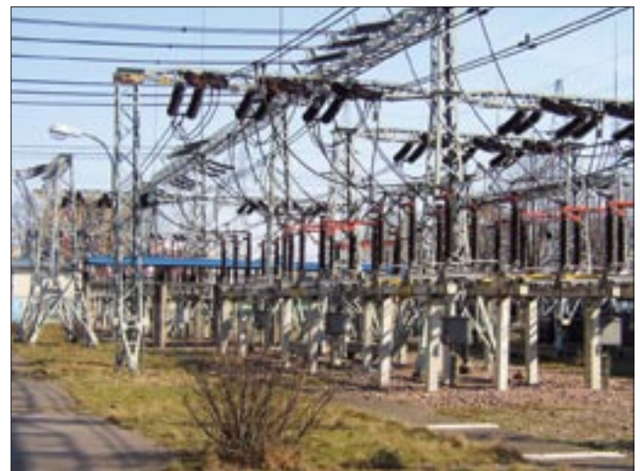
Rozdzielnia WN 110 kV
