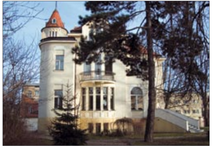
Willa na skrzyżowaniu ulic Gdańskiej i Kopernika. Pierwsza siedziba dyrekcji Elektrowni Łódzkiej
