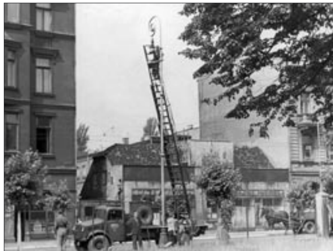
Brygada oświetlenia ulicznego
