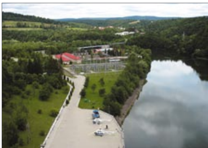
Rozdzielnia Hydroelektrowni Solina
