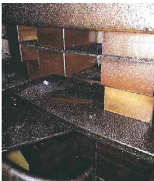
Zdjęcie 3. Zanieczyszczenie izolacji uzwojeń substancjami smolistymi rozkładu izolacji papierowej i oleju
