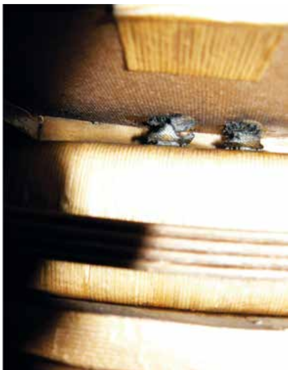
Zdjęcie 9. Uszkodzenie izolacji pierścienia ekwipotencjalnego uzwojenia RG oraz uszkodzenia kołnierza kąтового uzwojenia RG
