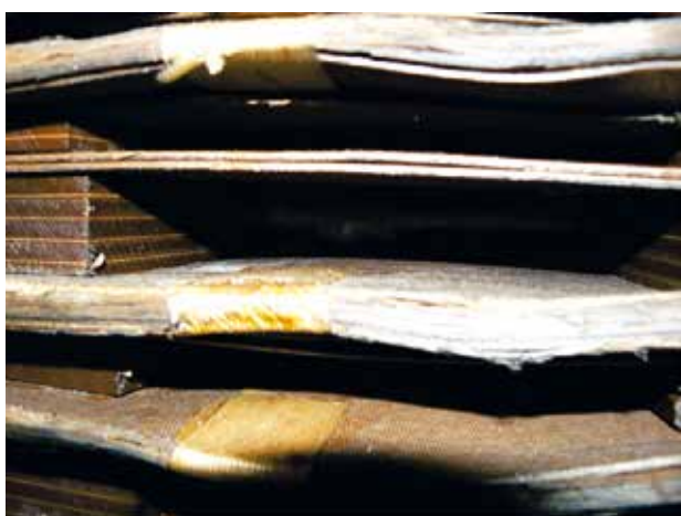
Zdjęcie 10. Uszkodzenie izolacji pierścienia ekwipotencjalnego uzwojenia GN
