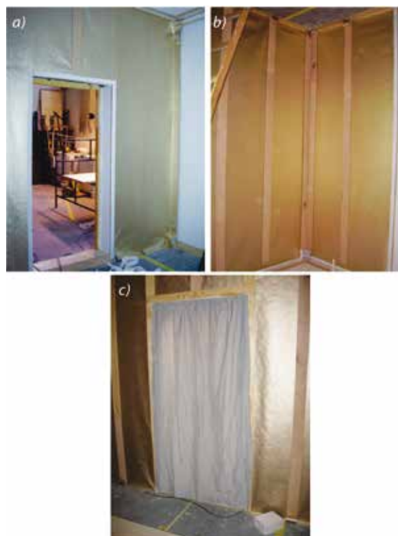
Rys. 6. a–c. Pomieszczenie budowlane „domek modelowy” z przykładowym sposobem montażu materiałów barierowych wewnątrz pomieszczenia
