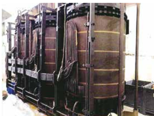
Zdjęcie 2. Część aktywna zanieczyszczona substancjami smolistymi rozkładu izolacji papierowej i oleju
