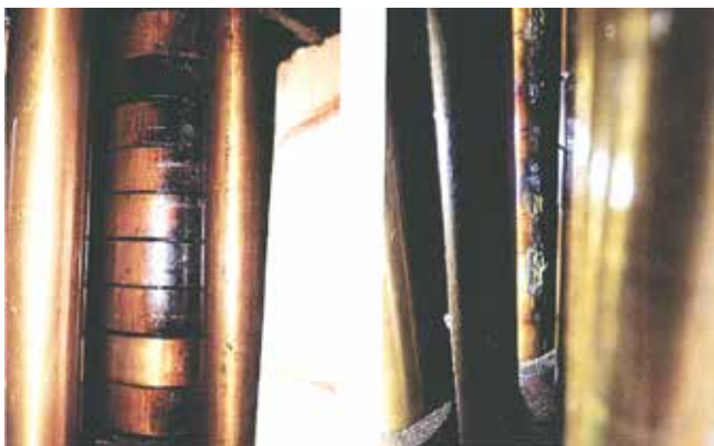
Zdjęcie 1. Wypalenia i przegrzania na beznapięciowych jednofazowych przełącznikach zacsepów
