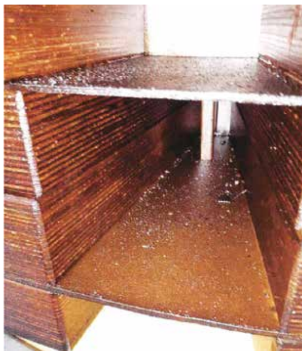
Zdjęcie 4. Ślady drobin, opiłków metalicznych na elementach izolacji wyrównawczej
