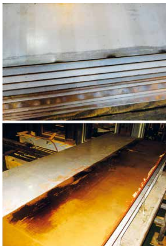
Zdjęcie 6. Uszkodzone i przegrzane blachy rdzenia
