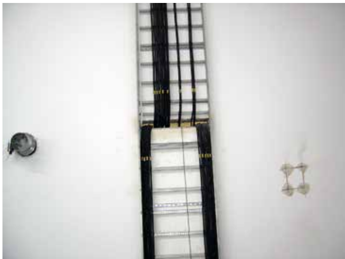
Instalacje w szachtach przed zabudową
