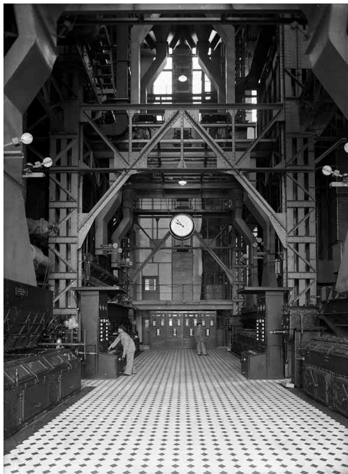
Centrala Zachód – kotłownia
