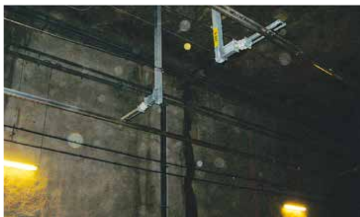
Rys. 7. Mocowanie sztywnej sieci trakcyjnej w obszarze tunelu z widocznymi izolatorami szynoprzewodu
