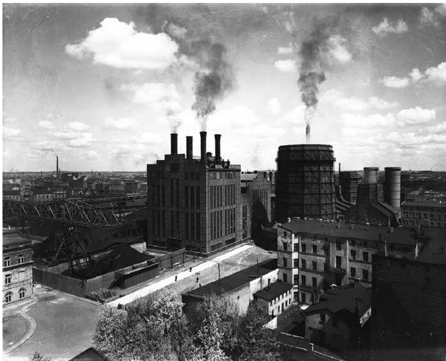
Elektrownia Łódzka – widok od strony zachodniej
