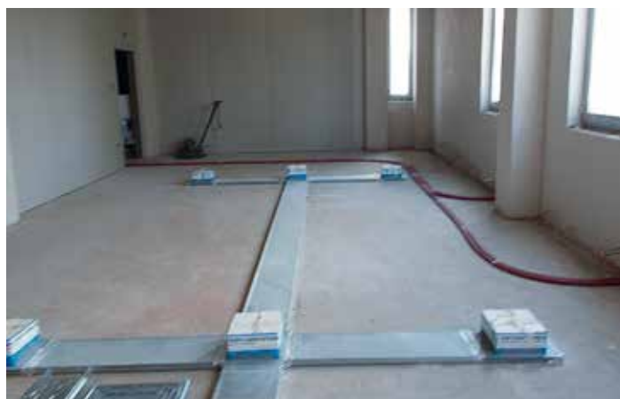
Instalacja podposadzkowa – trasy kablowe do floorboxów
