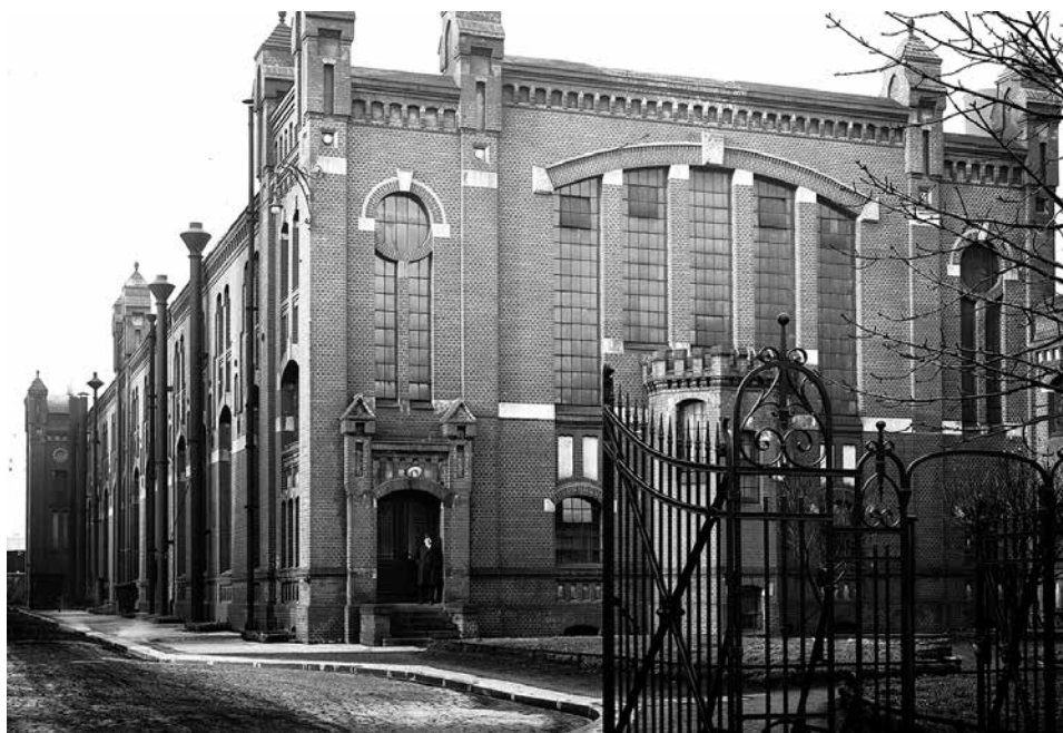
Centrala „Wschód” – budynek maszynowni
