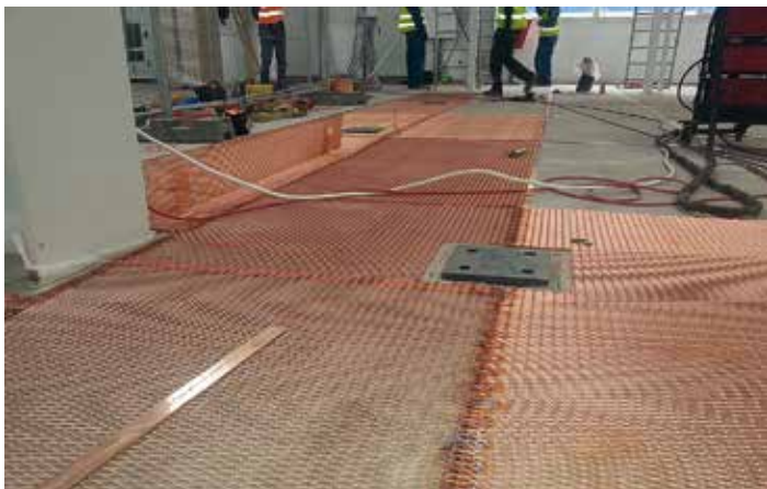
Instalacja podposadzkowa – połączenia ekwipotencjalne w pomieszczeniu laboratoryjnym
