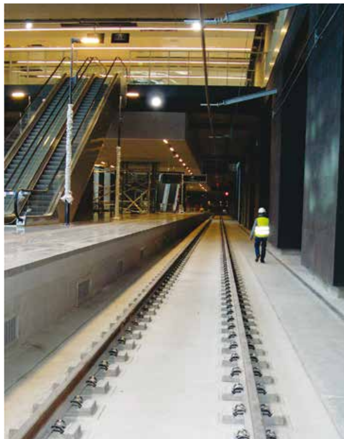
Rys. 8. Mocowanie sztywnej sieci trakcyjnej w obszarze stacji
