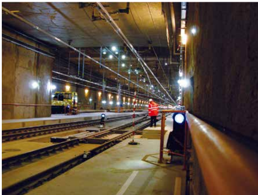
Rys. 9. Sieć trakcyjna sztywna w rejonie przejścia rozjazdowego w tunelu (na fotografii nad biało-czerwonym wskaźnikiem widoczny jest element przejściowy dla równoległego połączenia szynoprzewodów)
