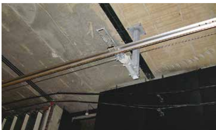
Rys. 6. Mocowanie sztywnej sieci trakcyjnej w obszarze tunelu z widocznym uszynieniem w postaci linki
