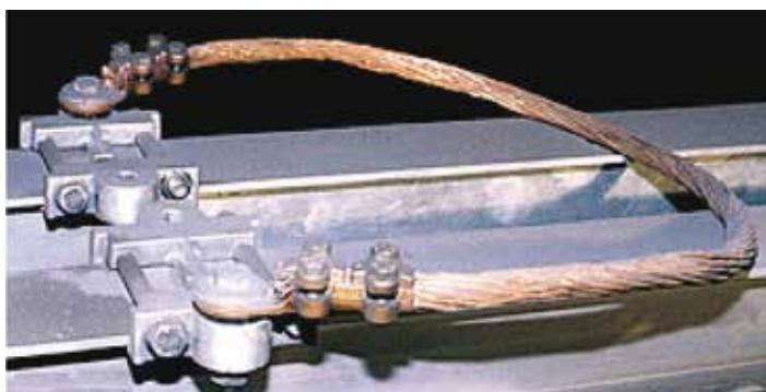
Rys. 3. Połączenie elektryczne szynoprzewodu za pomocą linki miedzianej
