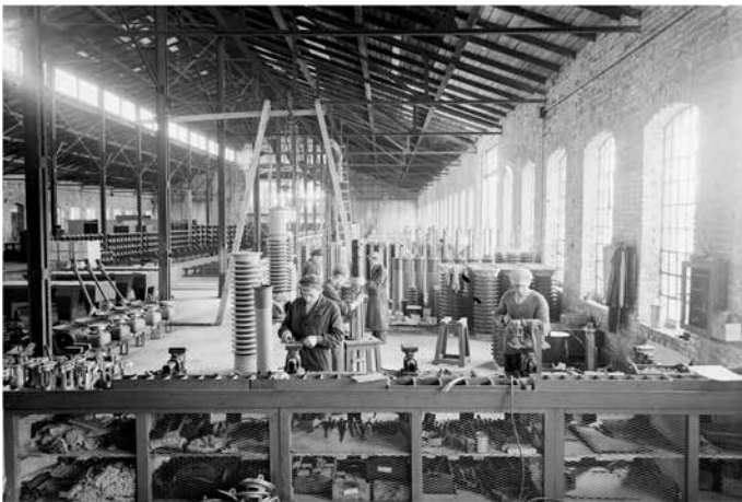
Hala produkcyjna w Międzyzlesiu, montaż aparatury na napięcie 150 kV
