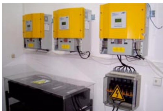
Rys. 3. Inwertery i akumulatory zasobnika energii Sunny Island
