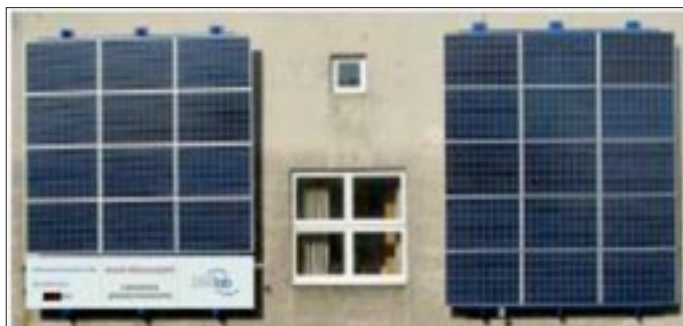
Rys. 1. Panele fotowoltaiczne na ścianie budynku
