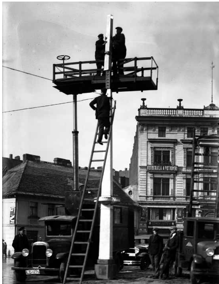
Montaż latarni na Placu Wolności
