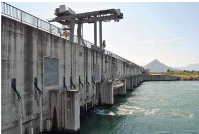
Elektrownia Wodna Ashta
