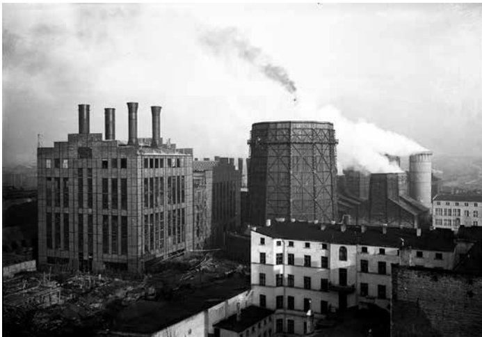
Widok elektrowni od strony zachodniej
