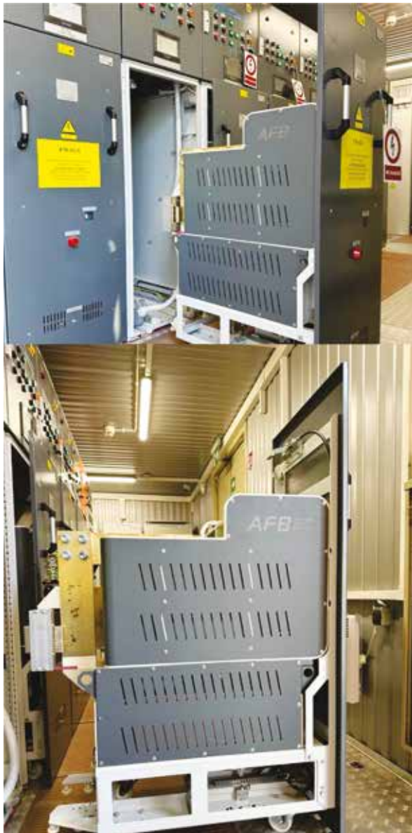
Rys. 1. Ultraszybki wyłącznik próżniowy prądu stałego typu AFB-25 (foto autor)
