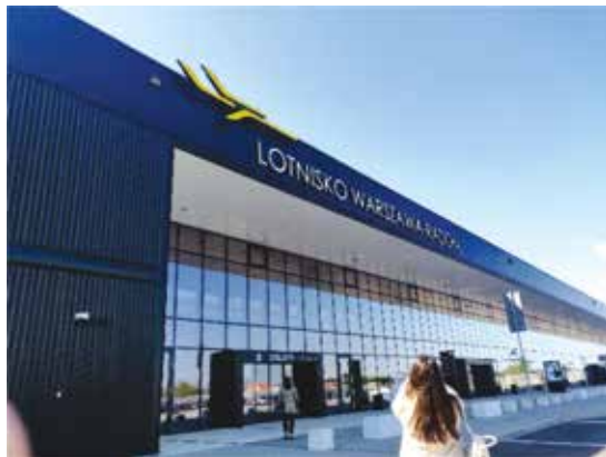
Widok zewnętrzny hali Lotniska Warszawa-Radom
