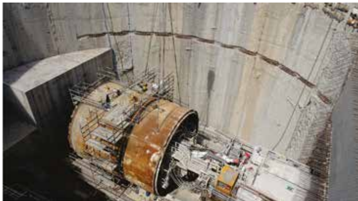
Rys. 3. TBM Faustyna, przygotowania do drążenia tunelu w kierunku Łódź Żabieniec (fot. A. Gawrysiak)
