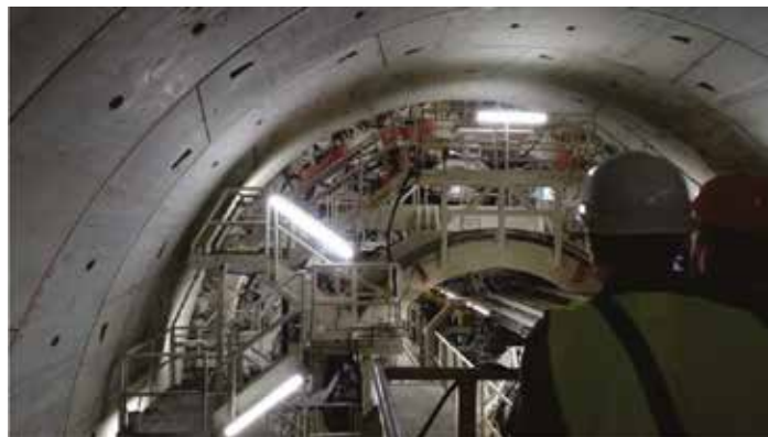
Rys. 6. TBM Katarzyna od środka (fot. A. Gawrysiak)
