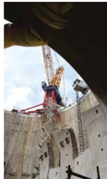
Rys. 5. Dźwig nad komorą wschodnią (fot. A. Gawrysiak)
