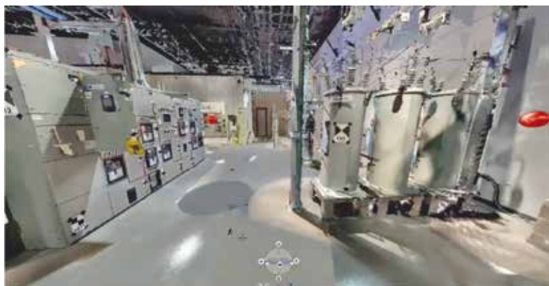
Skan laserowy 3D z naniesioną fotografią obiektu
