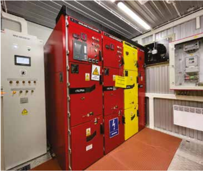
Rys. 6. Rozdzielnica RSN część odbiorcza (foto Gleb Shargay)
