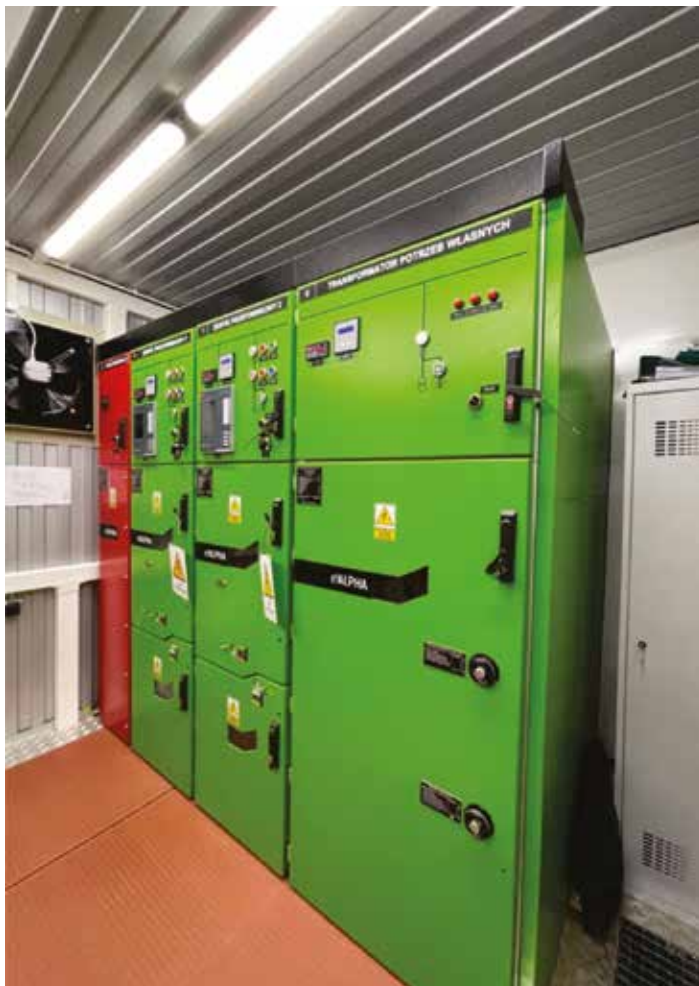
Rys. 7. Rozdzielnica RSN część zdawcza (foto Gleb Shargay)
