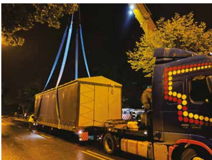
Rys. 2–3. Ulica Łąkowa w Zgierzu, transport oraz rozładunek kontenerowego modułu podstacji trakcyjnej „Łąkowa” (foto autor)
