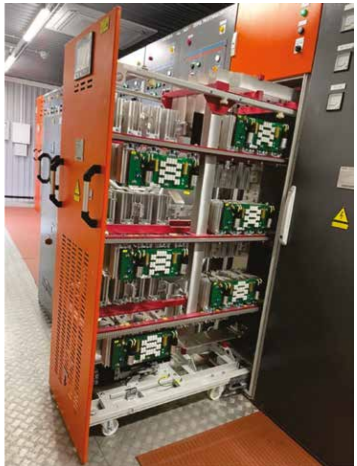
Rys. 9. Wyszynny prostownik typ V-TPED-1,2k (foto autor)
