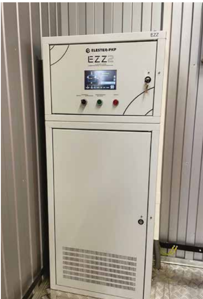
Rys. 10. Elektroniczne zabezpieczenie ziemno-zwarciove EZZ-2 (foto autor)
