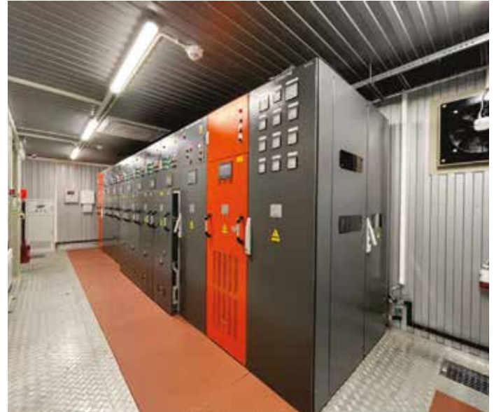
Rys. 8. Rozdzielnica RPS (foto Gleb Shargay)
