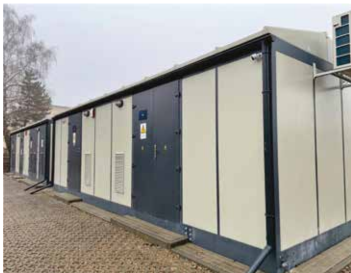
Rys. 4–5. Ulica Łąkowa w Zgierzu, podstacja trakcyjna „Łąkowa” wykonana w dwóch modułach kontenerowych (foto autor)
