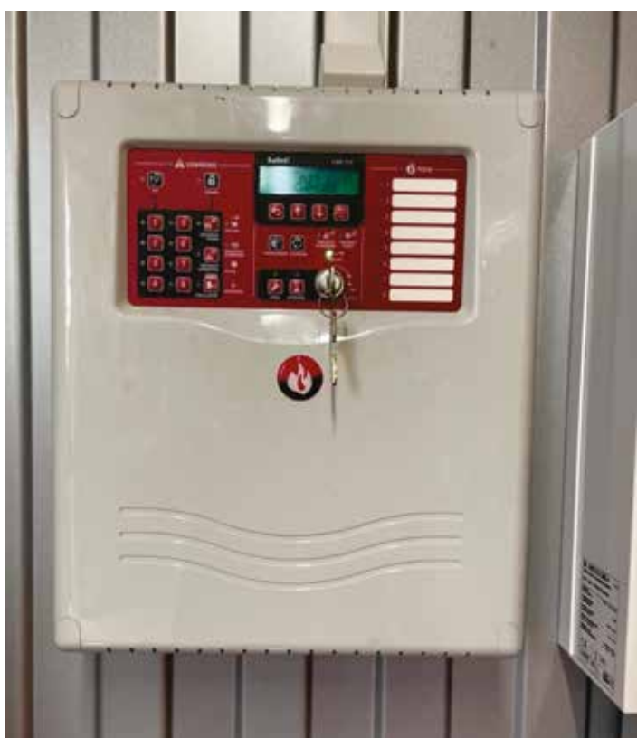
Rys. 11. Centralka pożarowo-włamaniowa (foto autor)
