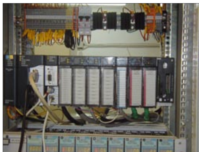
Rys. 4. Konfiguracja sprzętowa sterownika PLC modułu BOTT dla turbiny 200 MW
