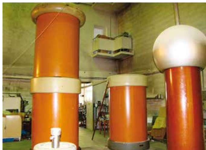
Rys. 13. Kaskada transformatorów probierczych 2x300 kV w hali wysokich napięć laboratorium wysokonapięciowego Politechniki Łódzkiej, zbudowanego pod kierownictwem prof. Zygmunta Hastermana
