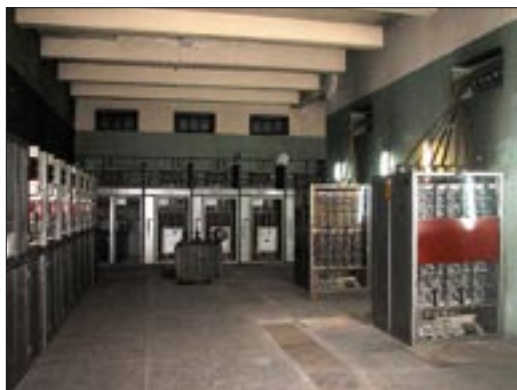
Hala główna podstacji przed przebudową
