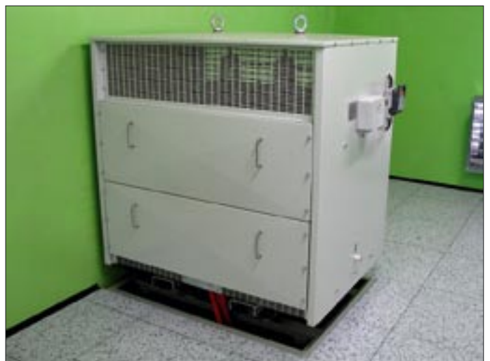
Transformator potrzeb własnych w obudowie IP23
