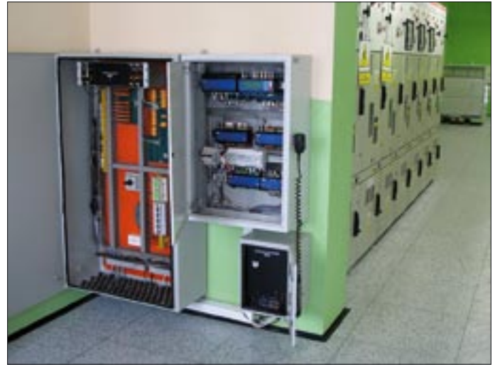
Szafa obiektowa telemechaniki i urządzenia łączności
