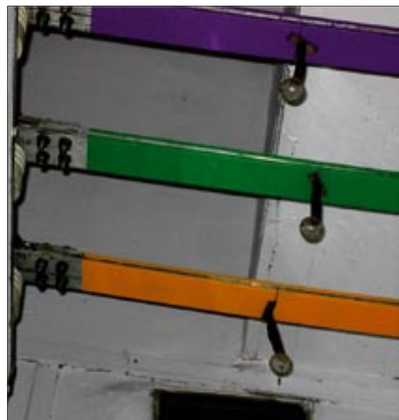
Rys. 4. Szynowe wskaźniki neonowe
