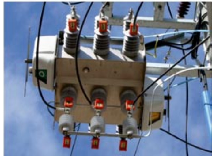
Rys. 6. Przykładowe instalacje wyposażone we wskaźniki VisiVolt: a) szyny prądowe instalacji wewnętrznej 6kV; b) transformator rozdzielczy; c) rozłącznik napowietrzny izolowany gazem
