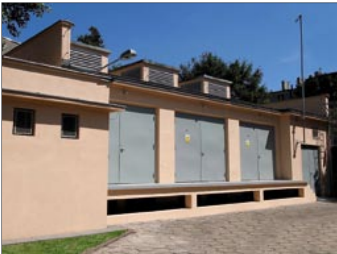
Budynek stacji prostownikowej po remoncie
