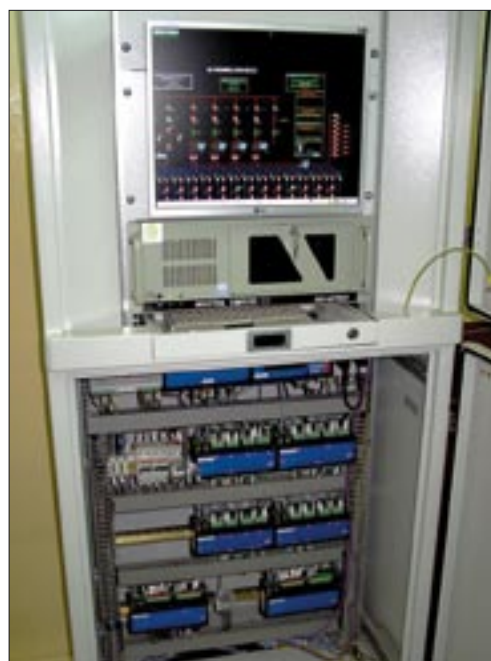
Szafa telemechaniki i terminal podstacyjny
