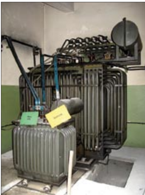
Transformator prostownikowy i dławik wyrównawczy
