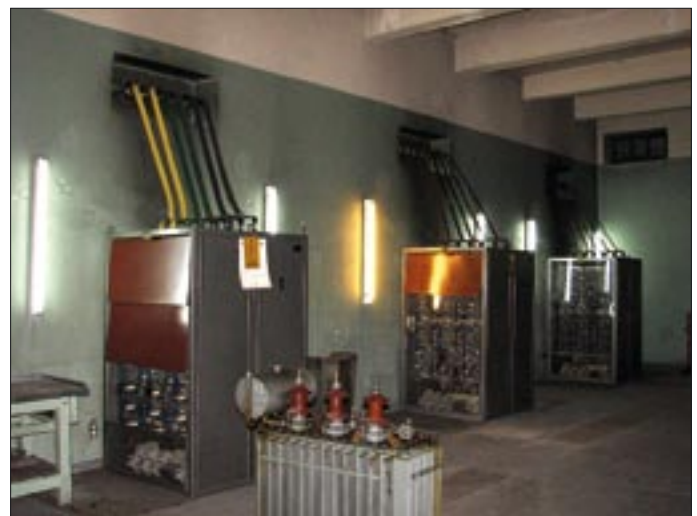
Wyeksploatowane prostowniki PK-09/0,66
