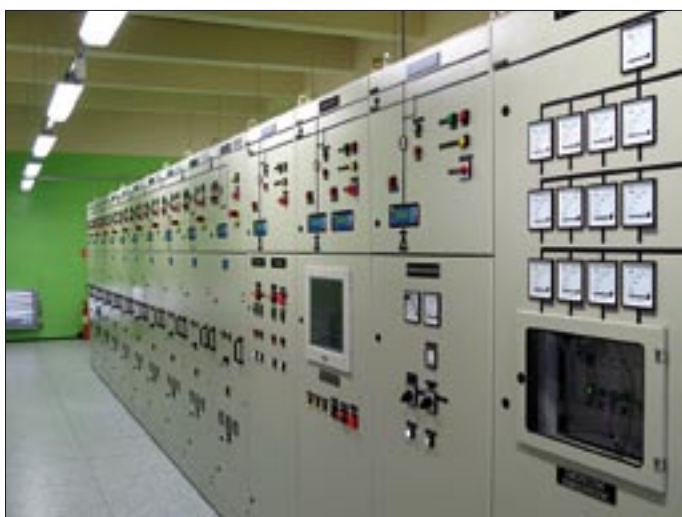
Rozdzielnica 660 V z automatyką CZAT 3000plus
