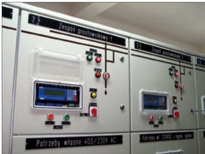
Nowa rozdzielnica 660 V na stacji Przechodnia
