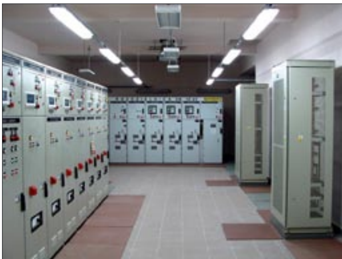
Hala stacji prostownikowej zasilającej ŁTR
