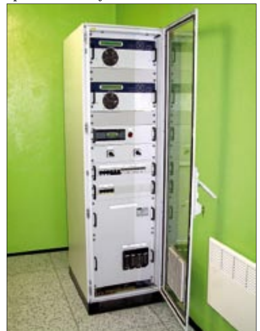
Siłownia prądu stałego 220 V
