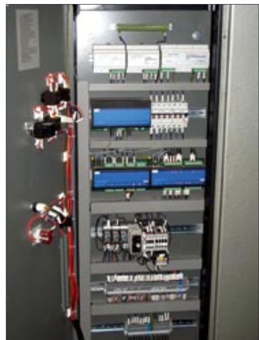
Obwody wtórne zmodernizowanej rozdzielnicy 660V
