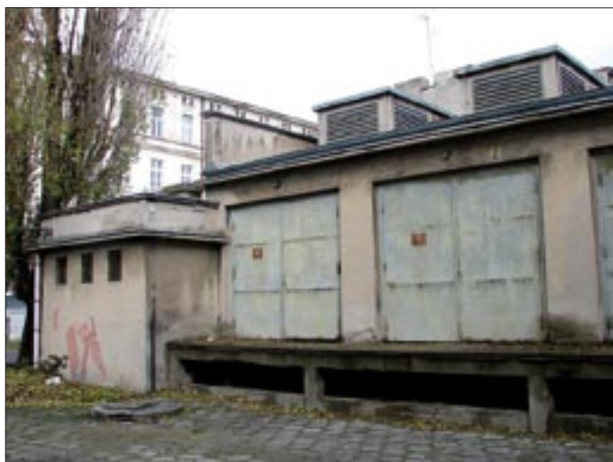
Budynek stacji prostownikowej przed remontem
