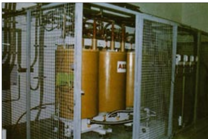
Rys. 6. Kriotransformator o mocy 630 kVA, 18,7/0,42 kV z uzwojeniami HTS (BSCCO - 2223) zainstalowany w Genewie. Przebadany przez ABB Brown Boveri Ltd. (IEEE Spectrum 1997 [4])
