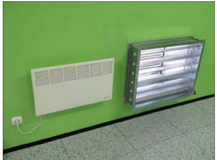
Grzejniki panelowe i elektrycznie sterowane żaluzje
