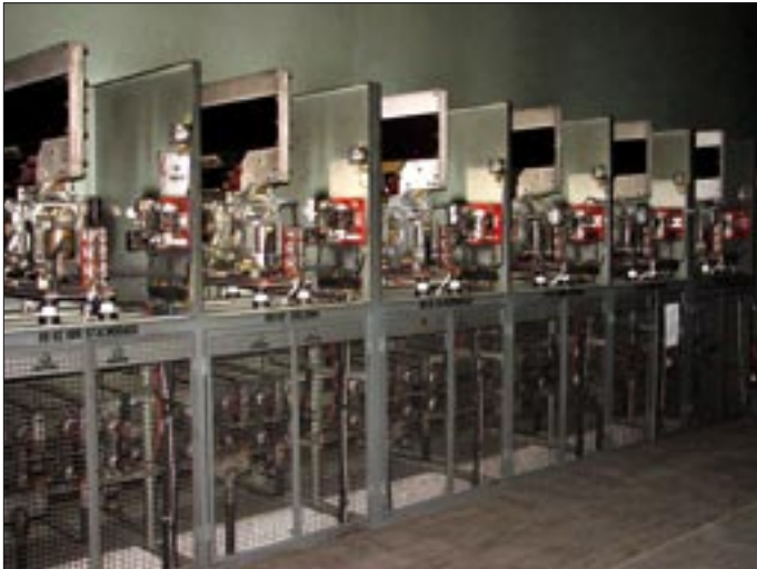
Rozdzielnica 600 V z wyłącznikami szybkimi WSe
