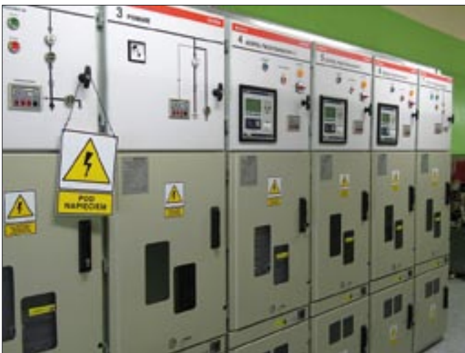
Rozdzielnica 15 kV z zabezpieczeniami megaMUZ
