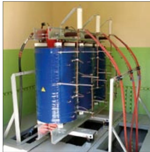
„Transformator prostownikowy TZM3T-1200/15
