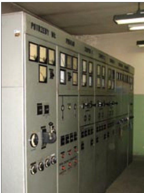
Tablica sterownicza w pomieszczeniu nastawni
