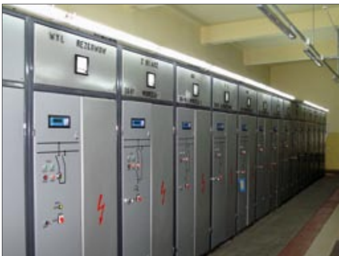
Zmodernizowana rozdzielnica prądu stałego 660 V
