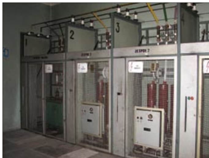
Rozdzielnica 6 kV z wyłącznikami WMRWS
