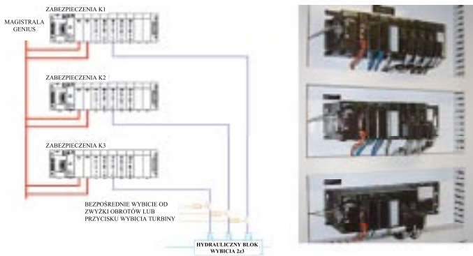
Rys. 3. Architektura trójkanałowego układu zabezpieczeń oraz widok szafy
