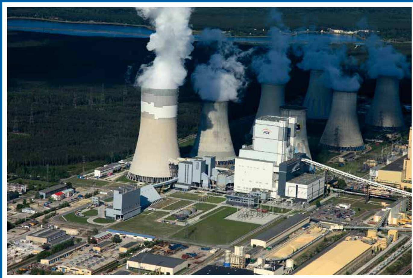
Blok 858 MW w Elektrowni Bełchatów
