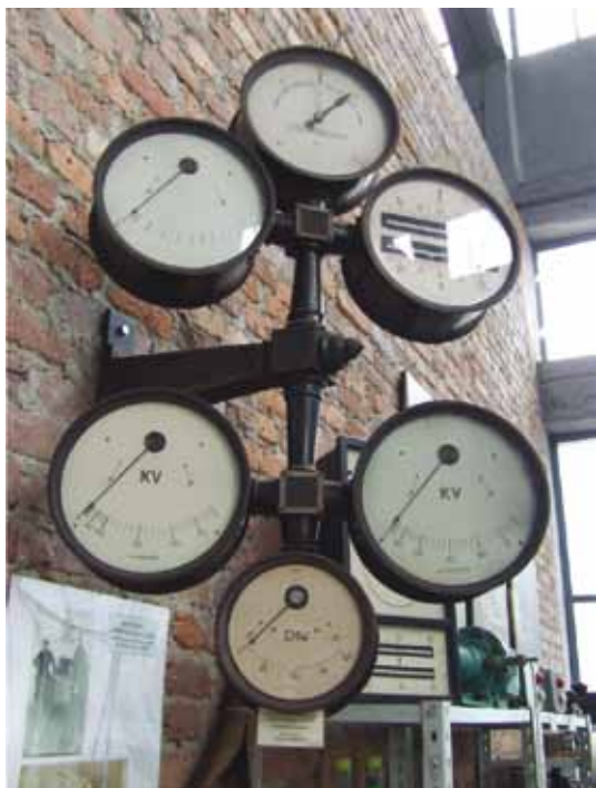
Fot. 25. Kolumna synchronizacyjna Trüb Träuber Zurich z pierwszej siłowni Elektrowni Łaziska
