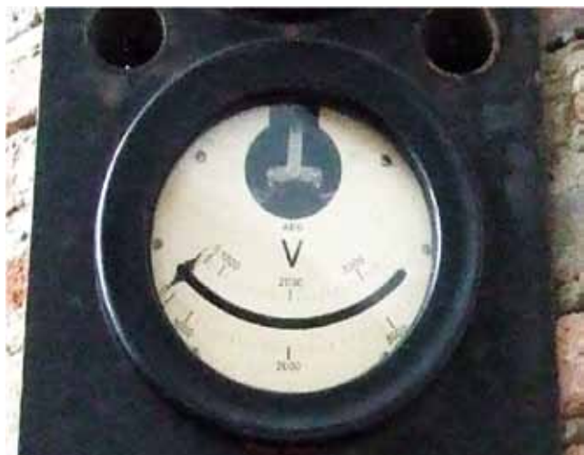
Fot. 6. Podwójny woltomierz napięcia przemiennego firmy AEG umożliwiający szybką ocenę różnicy napięcia generatora i sieci
