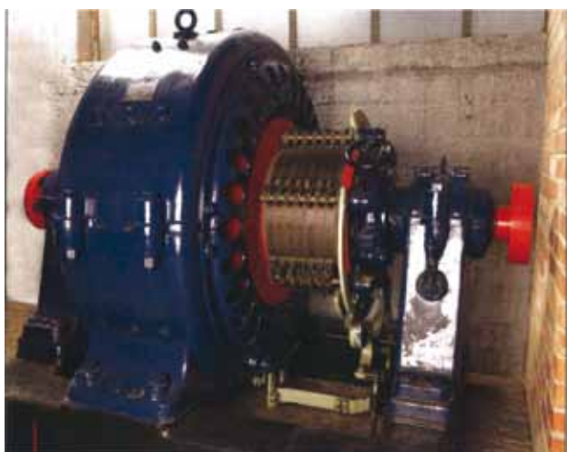
Fot. 14. Generator firmy BROWN-BOVERI o mocy 500 kW, pochodzący z niemieckiego pancernika Gneisenau z II wojny światowej
