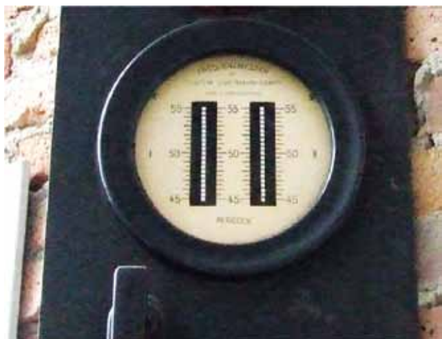
Fot. 7. Podwójny wibracyjny miernik częstotliwości umożliwiający szybką ocenę różnicy częstotliwości generatora i sieci
