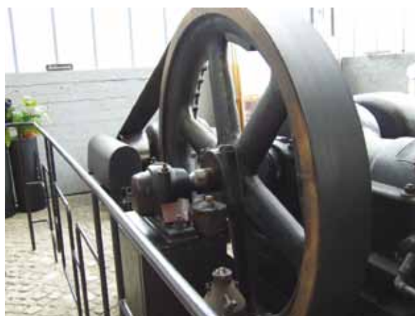
Fot. 10. Agregat składa się z silnika gazowego połączonego z generatorem prądu za pomocą pasa transmisyjnego. Wielkie koło pasowe silnika przypomina maszynę parową. Należy jednak pamiętać, że w cylindrach spalany był biogaz
