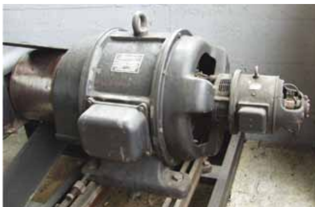
Fot. 12. Napędzana silnikiem DEUTZ prądnica 220 V o mocy 125 kVA, produkcji Sachsenwerk Niedersiedlitz z Drezna
