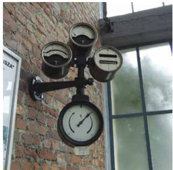
Fot. 24. Kolumna synchronizacyjna z elektrowni przy kopalni „Czerwionka Leszczyny”
