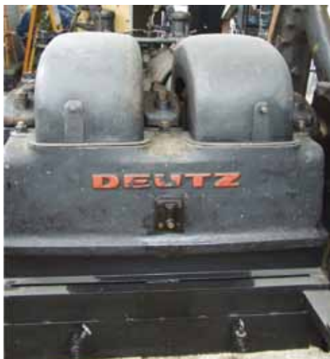
Fot. 11. Generator jest napędzany silnikiem DEUTZ pracującym na biogaz. Agregat pracował w oczyszczalni ścieków w Bytomiu. Ścieki oczyszczano przez napowietrzanie kompresorem elektrycznym, zasilanym ze wspomnianego generatora. Mamy więc do czynienia ze swoistym „perpetuum mobile”, które dodatkowo dostarczało energię elektryczną do oświetlenia i ogrzewania oczyszczalni
