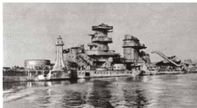
Fot. 16. Zatopiony wrak Gneisenau górował nad portem uniemożliwiając swobodną żeglugę. Z wraku odzyskano kadłub kryjący 20 tysięcy ton wysokogatunkowej stali, setki ton metali kolorowych, tysiące kilometrów kabli, urządzenia, agregaty, które mogłyby oświetlić co najmniej dwa duże miasta
