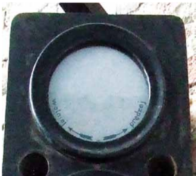
Fot. 5. Górny wskaźnik stanowił synchronoskop. Widoczne oznaczenie „wolniej prędej” odnosiło się do szybkości obrotowej generatora
