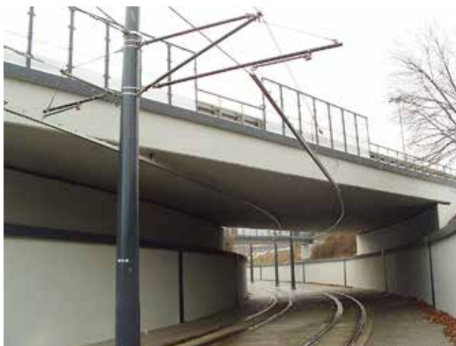
Sieć trakcyjna sztywna wykonana szynoprzewodami. Jezdnia pod al. Bandurskiego
