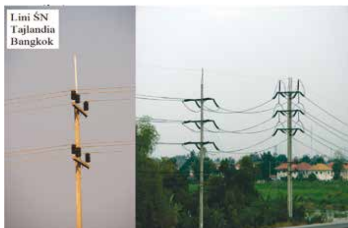
Rys. 2. Linia średniego napięcia z przewodem odgromowym wysuniętym dla ograniczenia składowej indukowanej napięcia na izolacji i podwyższenia piorunowego poziomu izolacji
