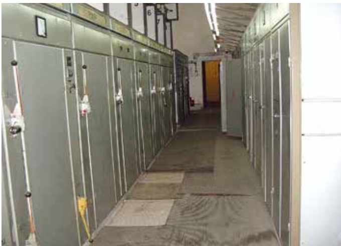
.Stara rozdzielnica: po lewo RSN-15kV, po prawo RPS. Podstacja „KOPERNIK”
