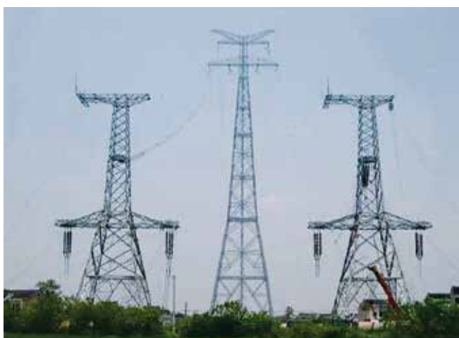
Rys. 6. Przęsło 500 kV nad rzeką Jianguin Yangtze w Chinach [8]
