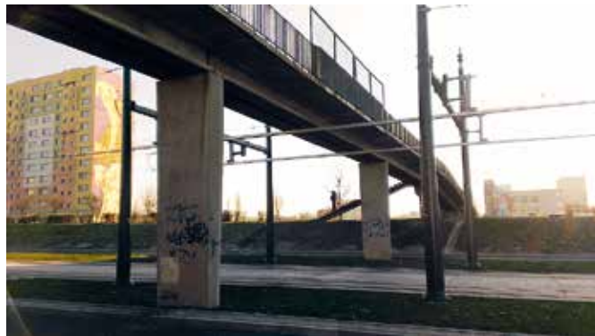
Sieć trakcyjna sztywna wykonana szynoprzewodami. Torowisko pod kładką Al. Wyszyńskiego
