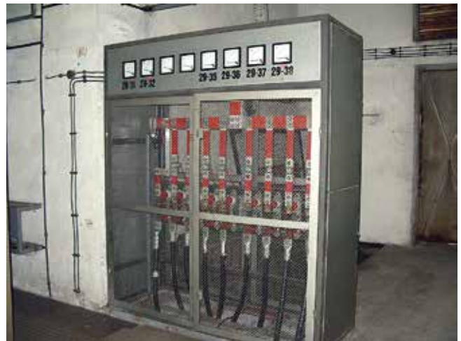
Stara szafa kabli powrotnych. Podstacja „KOPERNIK”
