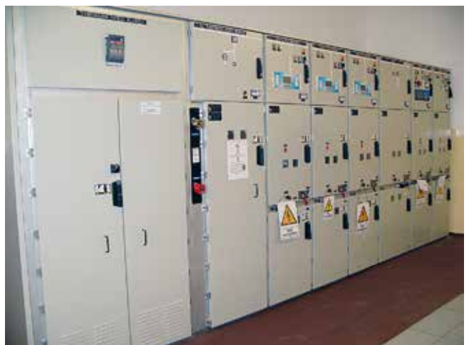
Nowa rozdzielnica 15 kV (RSN). Podstacja „KOPERNIK”
