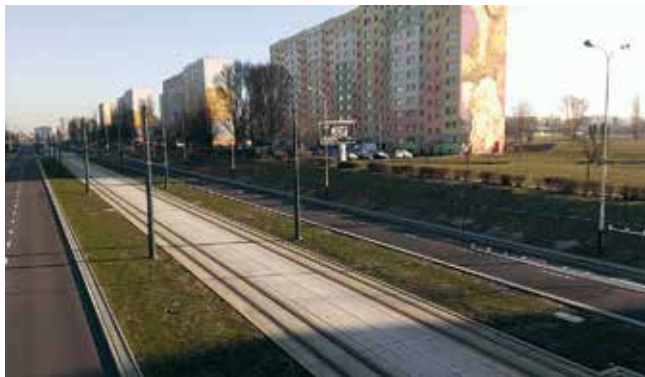
.Zmodernizowana sieć trakcyjna wraz z torowiskiem przystosowanym do wspólnego ruchu tramwaju i autobusu. Al. Wyszyńskiego
