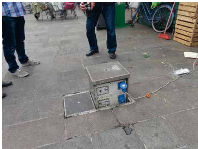
Rozdzielnica zasilająca stragany na placu w Padwie
