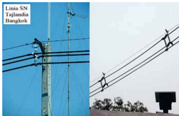
Rys. 3. Linie średniego napięcia z przewodami izolowanymi w systemie PAS
