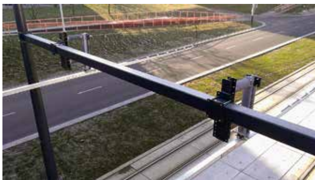
Izolator mocujący szynoprzewody pod kładką Al. Wyszyńskiego
