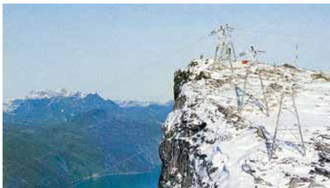
Rys. 5. Przęsło 132 kV nad fiordem Ameralik na Grenlandii [8]
