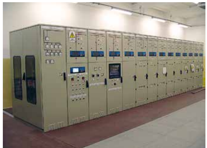
Nowa rozdzielnica prądu stałego (RPS). Podstacja „KOPERNIK”
