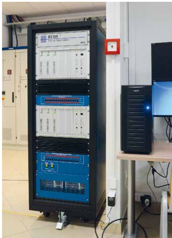
Stanowisko laboratoryjne do symulowania zakłóceń w czasie rzeczywistym (RTDS)
