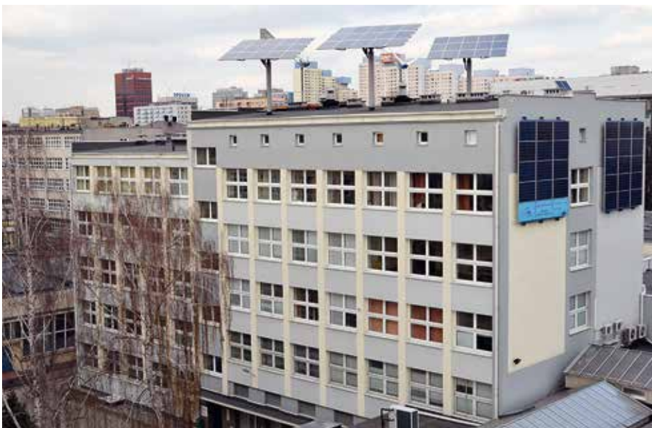
Budynek Instytutu Elektroenergetyki PŁ
