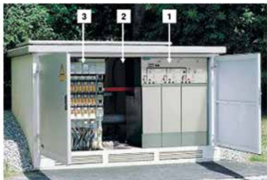
Rys. 2. Typowa stacja SN/Inn: 1 – rozdzielnica SN 8DJH, 2 – transformator dystrybucyjny, 3 – rozdzielnica niskiego napięcia
