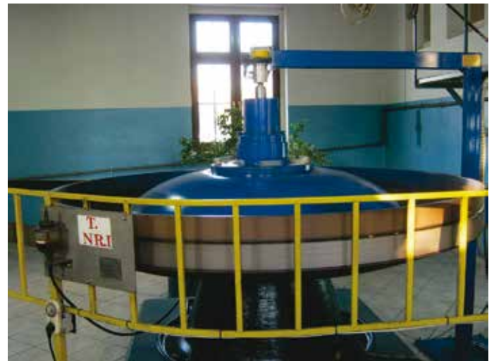
Fot. 3. Wnętrze elektrowni wodnej „Kujawska” (turbina nr 1), o całkowitej mocy 600 kW, na Brdzie
