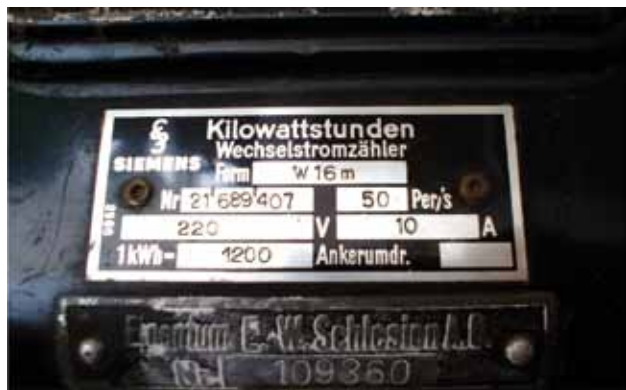
Fot. 23. Tabliczka własności poprzedniego właściciela licznika typ W16m (fot. 22.) – E.W. Schleisen AG. Liczniki stosowane były w Niemczech i w Polsce przed 1939 r.
