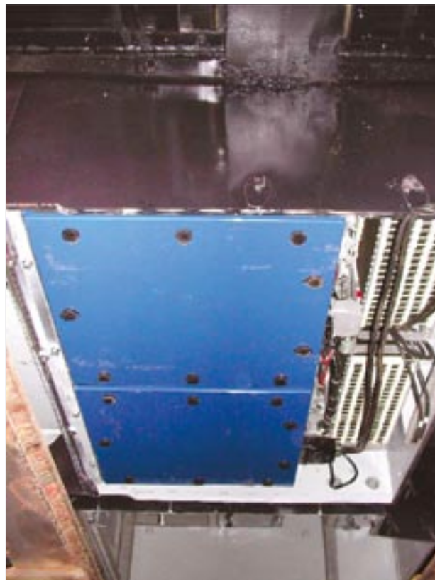
Rys. 9. Dwa falowniki oraz dwa rezystory hamowania we wnęce po rozruszniku
