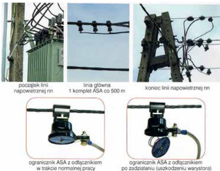
Rys. 9.1. Przykłady sposobu montowania ograniczników klasy A [8]
