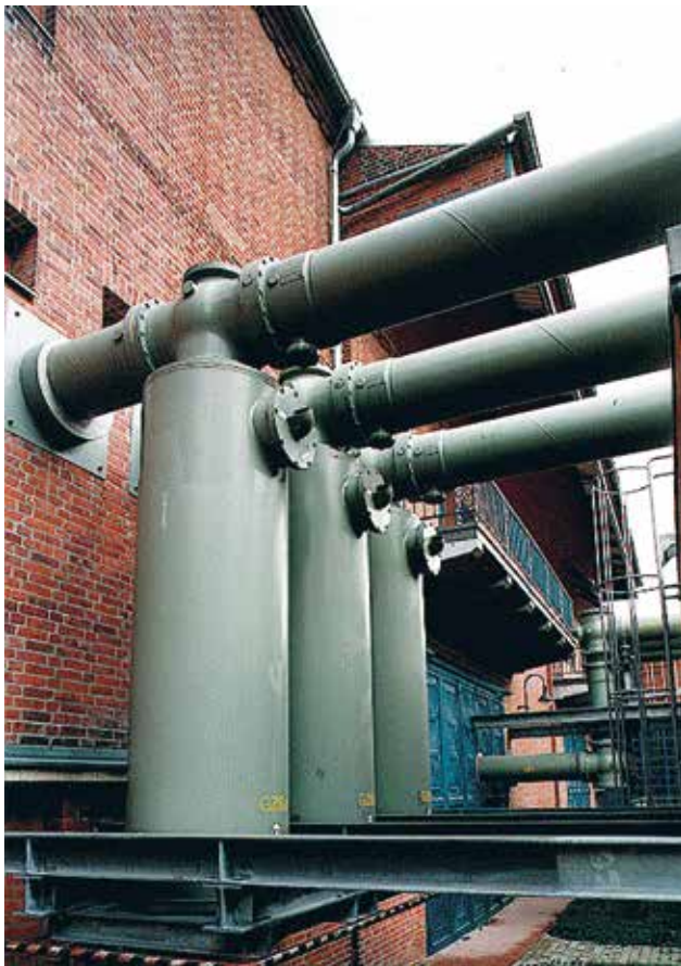
Rys. 10.7. Ogranicznik gazowy (SF6) instalowany na wejściu linii 420 kV [9]
