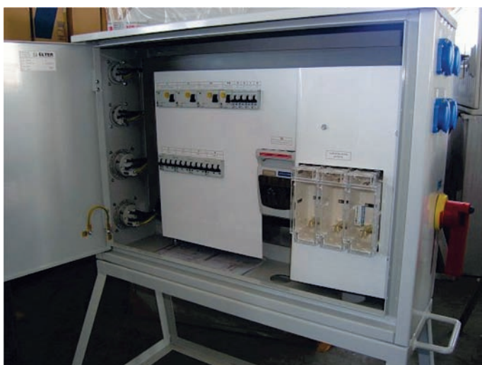
Rys. 4. Przykładowa rozdzielnic budowlana umieszczone w strefie III
