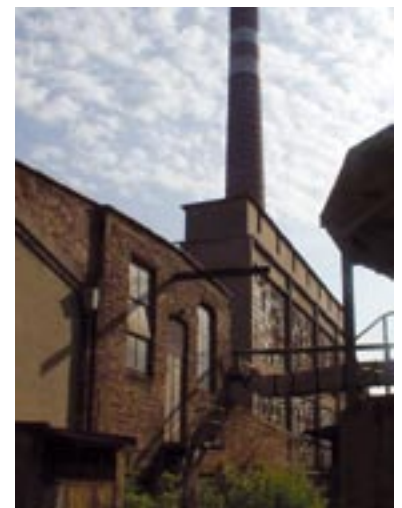
Rys. 4. Budynek nawęglania, z kominem w tle
