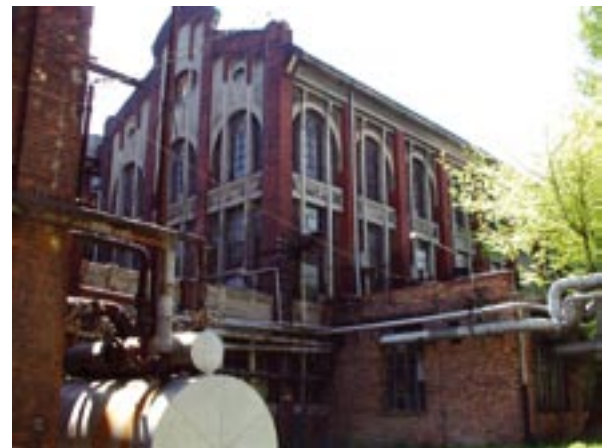
Rys. 2. Budynek główny, widok od strony północnej
