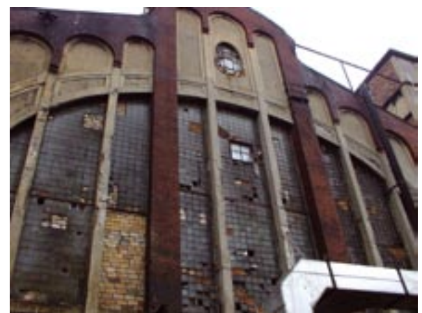
Rys. 3. Budynek główny, widok od strony zachodniej
